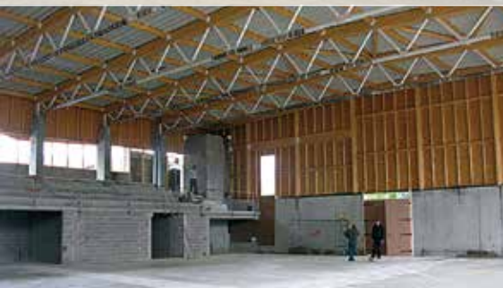
Mai 2013 : réalisation de l'étanchéité des toitures, dallages et maçonneries
