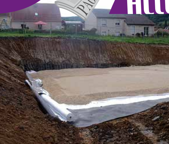
Août 2012 : terrassements et pose de la membrane d'étanchéité
