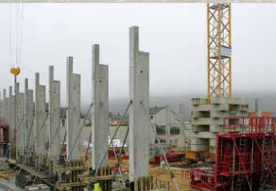
Novembre 2012 : montage des poteaux en béton préfabriqués
