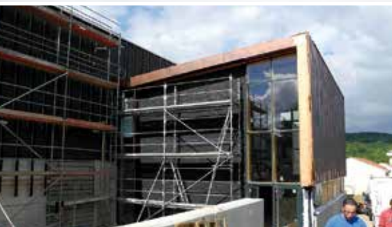
Juillet 2013 : pose des parements et des vitrages
