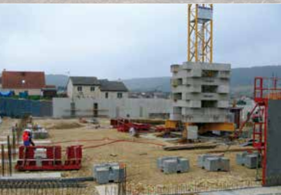
Octobre 2012 : montage de la grue et des voiles
