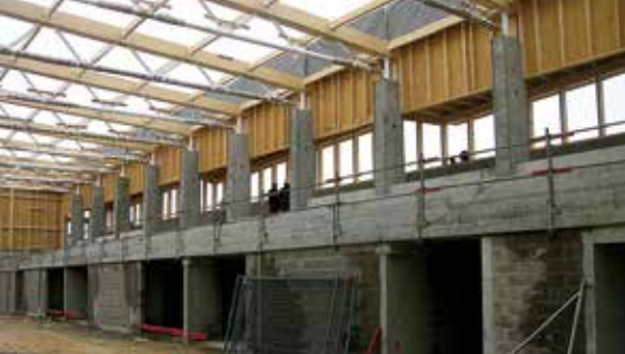
Fin février 2013 : montage de la charpente de la salle
