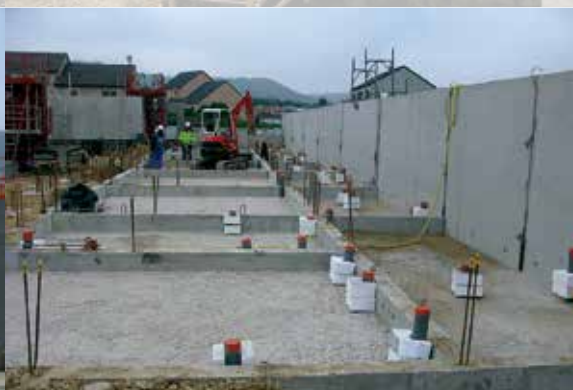
Novembre 2012 : incorporation des réseaux sous dallage
