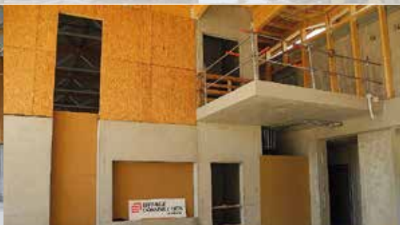
Juillet 2013 : pose des réseaux intérieurs
