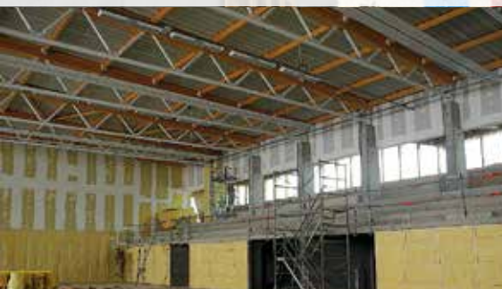
Août 2013 : réalisation des doublages et des finitions extérieures
