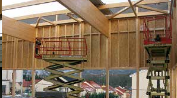
Mars 2013 : montage de la charpente du dojo
