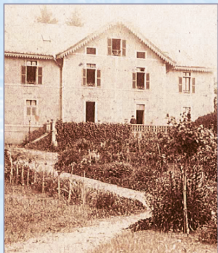
Moulin Bas, façade arrière de la maison Sandret
