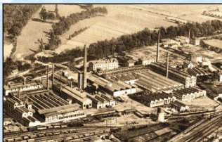
Cie Lorraine de Charbons pour l'Électricité, vue aérienne
